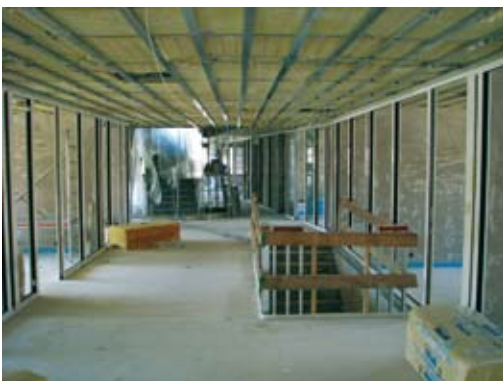
Auch im Inneren schreiten die Arbeiten voran – hier im Bürotrakt im 1. Stock
