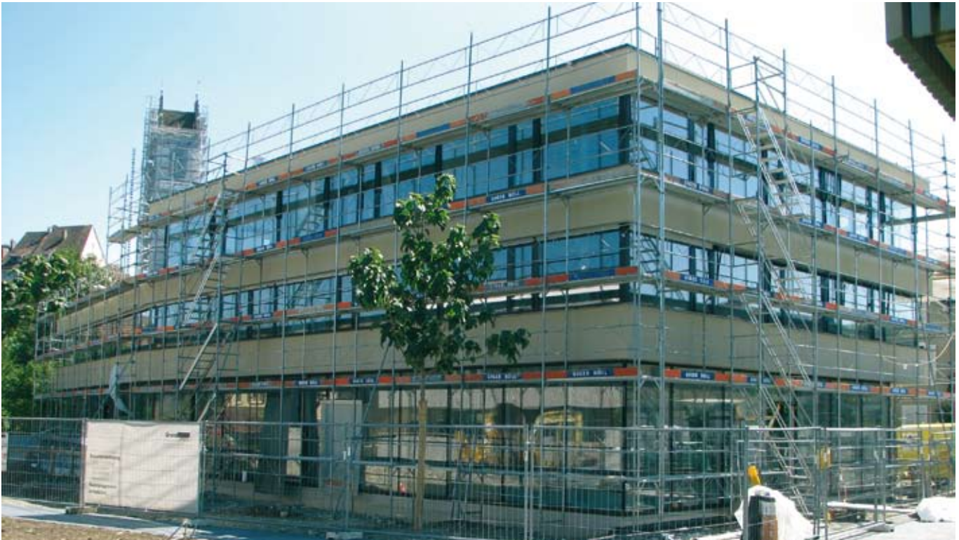
Die Fassade des Neubaus ist fertig. Ende August wird das Gerüst abgebaut
