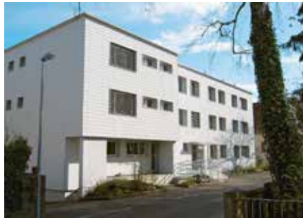
Der Heimgarten Brugg, eine der Liegenschaften, die im Besitz der Reformierten Landeskirche Aargau sind
